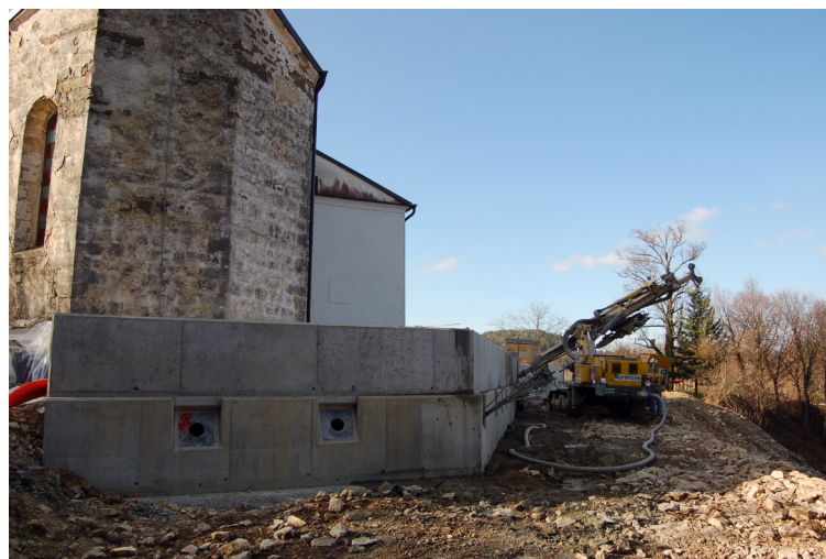
Jezusovo rojstvo v cerkvi Marijinega vnebovzetja (zgoraj) - Pogled na zunanjo fasado prezbiterija med utrjevanjem temeljev v isti cerkvi (spodaj)
